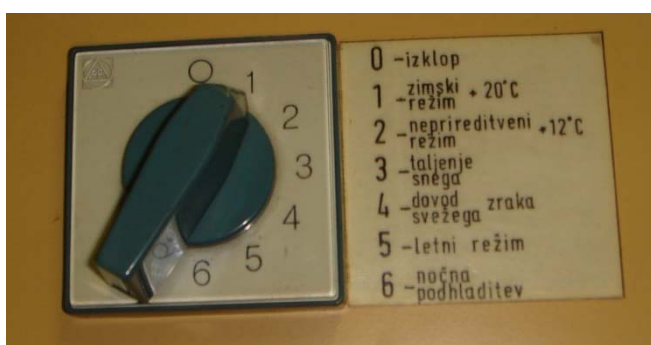
Slika 7.9: Posnetek gumba za ročno nastavitve režima delovanja klimata
