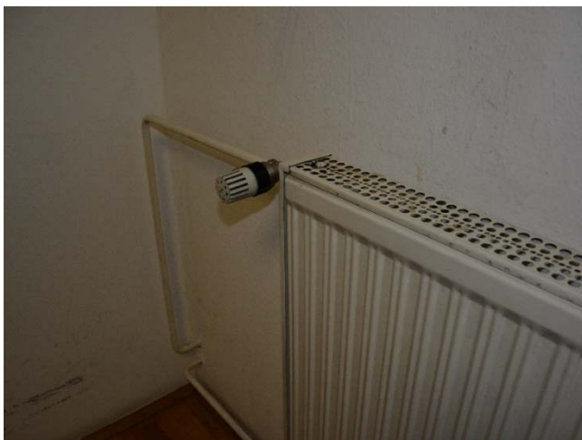
Slika 6.2: Radiator s termostatskim ventilom
