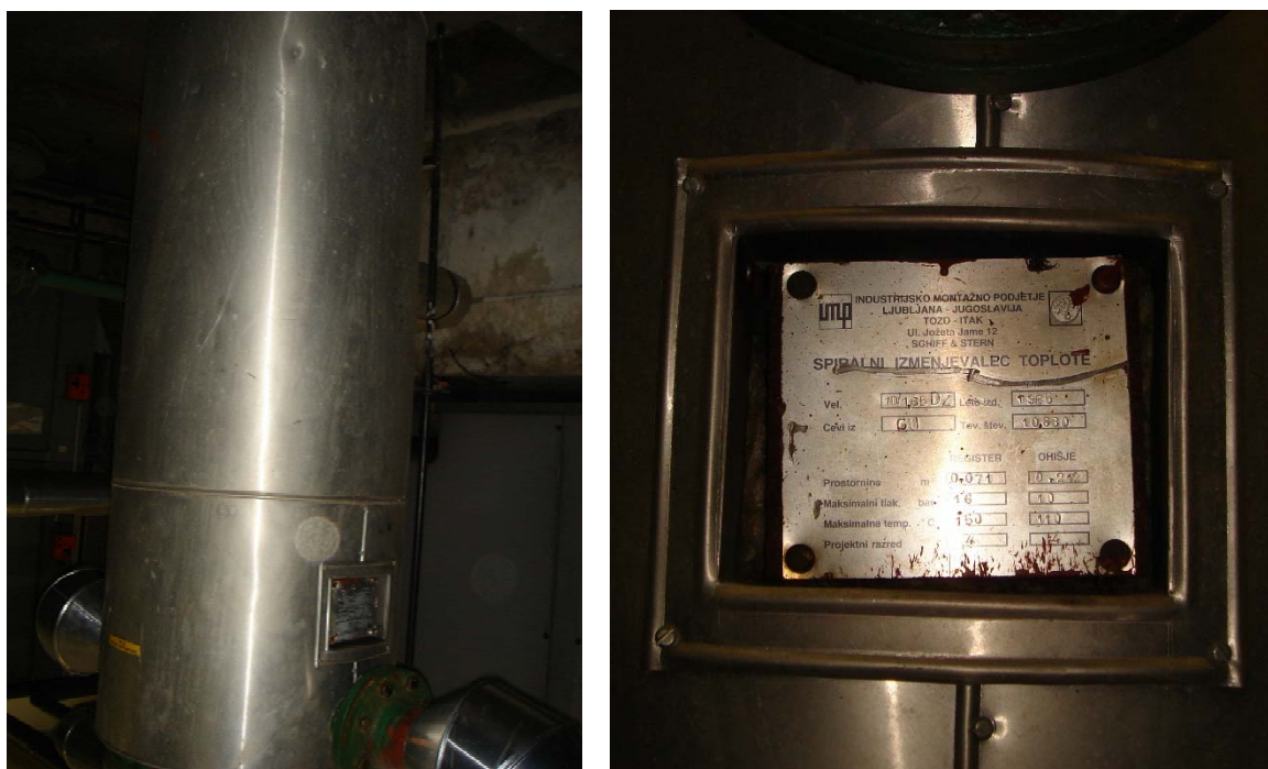
Slika 6.1: Spiralni prenosnik toplote (levo) in njegova napisna tablica (desno)
