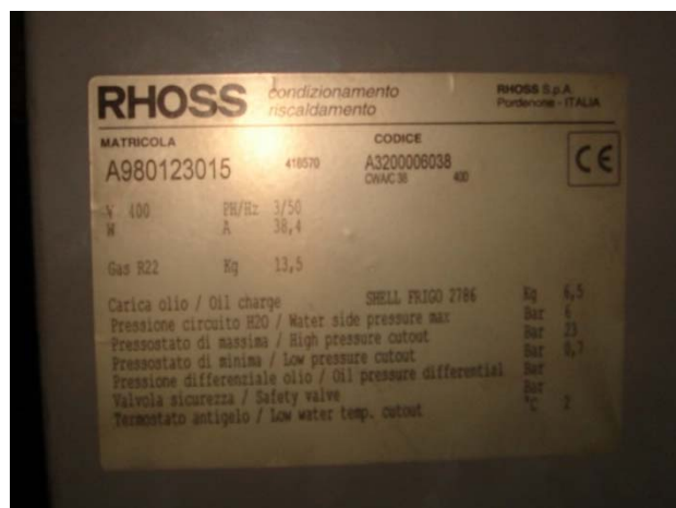
Slika 7.13: Posnetek nalepke s karakteristikami hladilnega agregata
