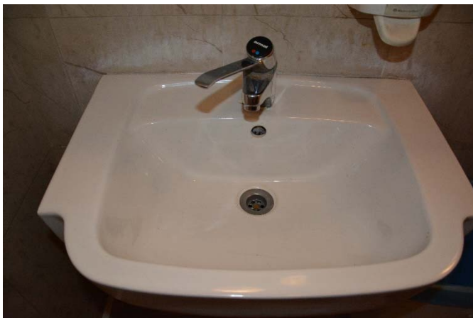
Slika 6.5: Posnetek umivalnika opremljenega z enoročno mešalno armaturo
